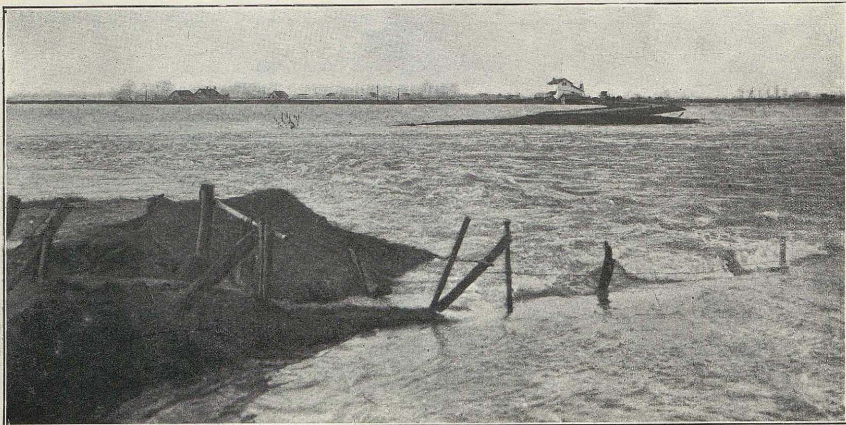
Rupture d'une digue à Cuyck, dans le Brabant hollandais. Cette catastrophe a mis sous l'eau d'immenses étendues de territoire, non loin de Bois-le-Duc ; des centaines de vaches ont été noyées, les habitants ont dû fuir devant le fléau qui envahissait leurs demeures.
